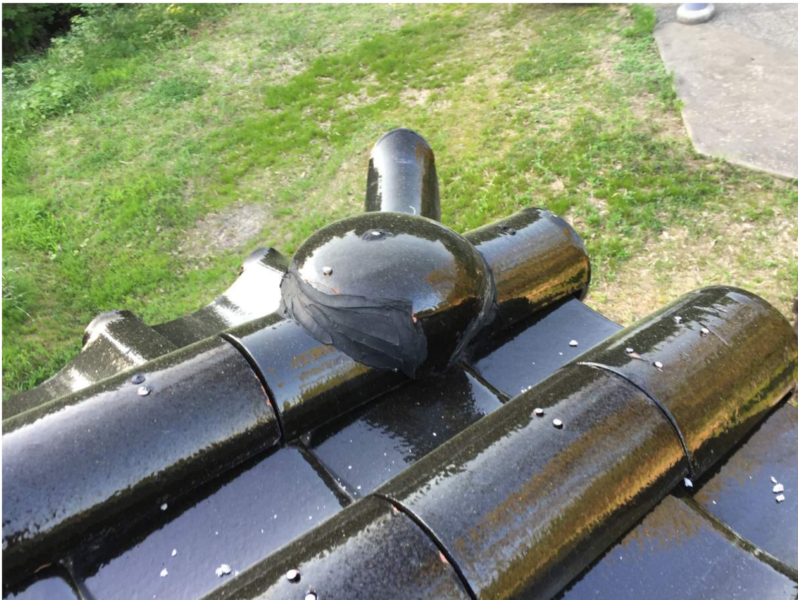
拝殿正面右側降り素丸最後の状況 前回修繕（眞田瓦店施工）時は補修でしたので今回は要交換。
