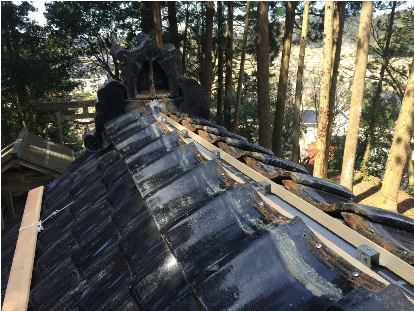
葺 一文字瓦施工 (ステンレスビス止)
