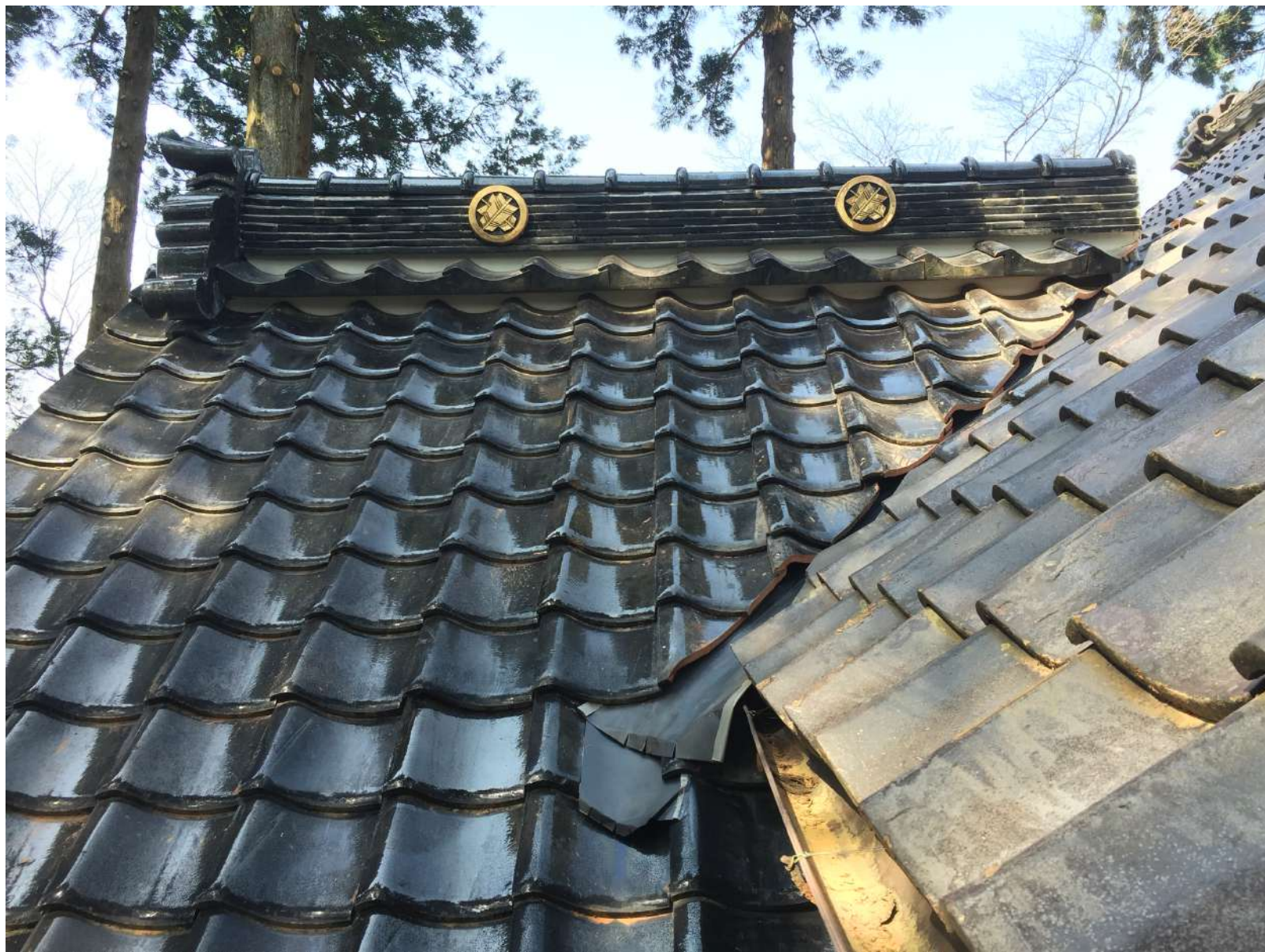
拝殿拝み屋根葺棟完成
