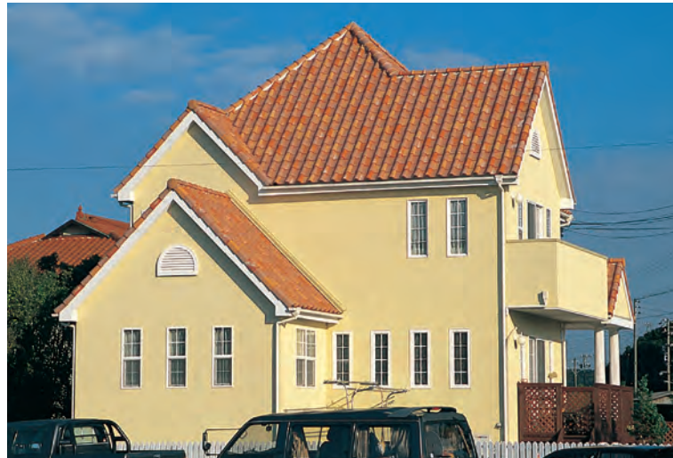
▲ユーロビーチ60%＋ユーロパウダー20%＋ユーロライト20%
