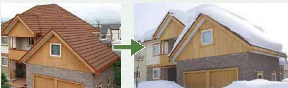
天然石ストーンチップを焼付けた表面加工の凹凸が積雪を屋根上でしっかりと止めて、勾配屋根での雪止め金具などと同等の効果を実証済みです。
