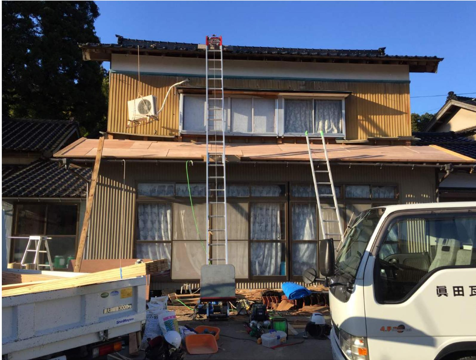
下地修正板張り後 ※屋根の端部分の瓦を安定させる瓦座が傷んでいたので交換しました。
